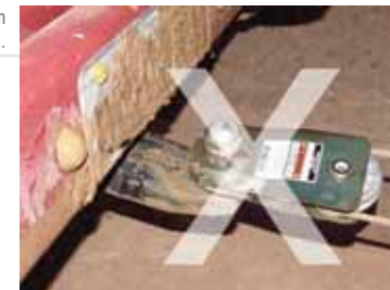
Manilha de ancoragem montada na maneira errada.
