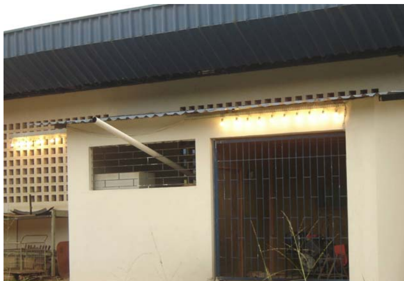
Figura 2. Vista geral da Estrutura montada para consumir a energia e acomodar o grupo gerador.
