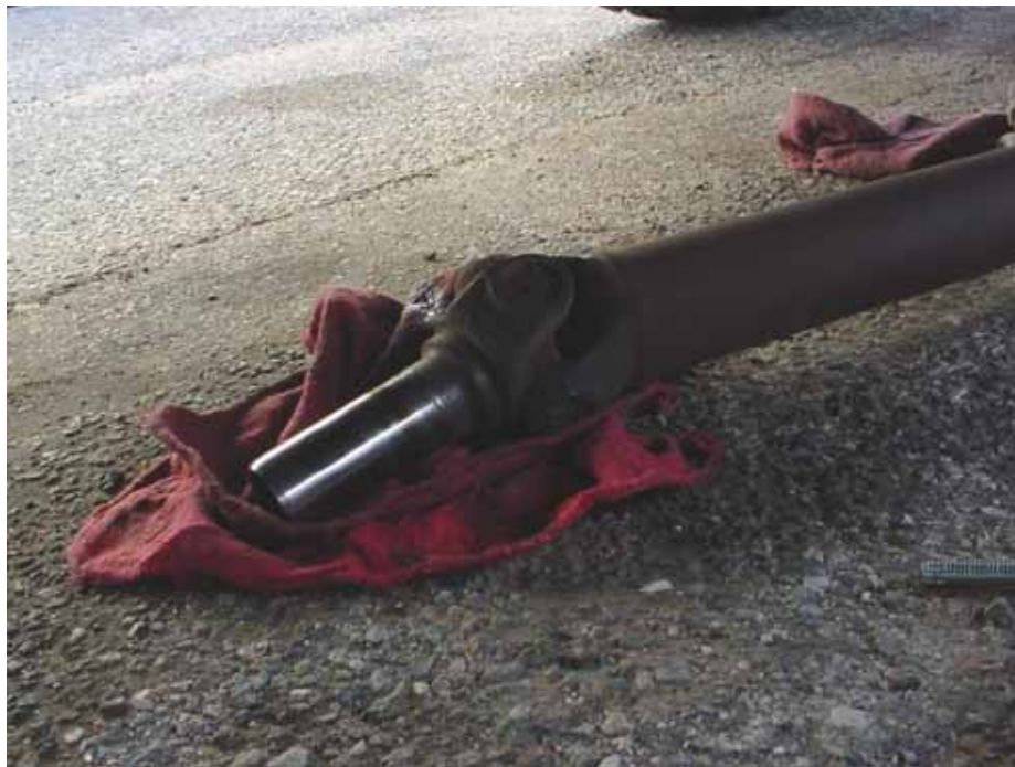
Remoção do cardã original
