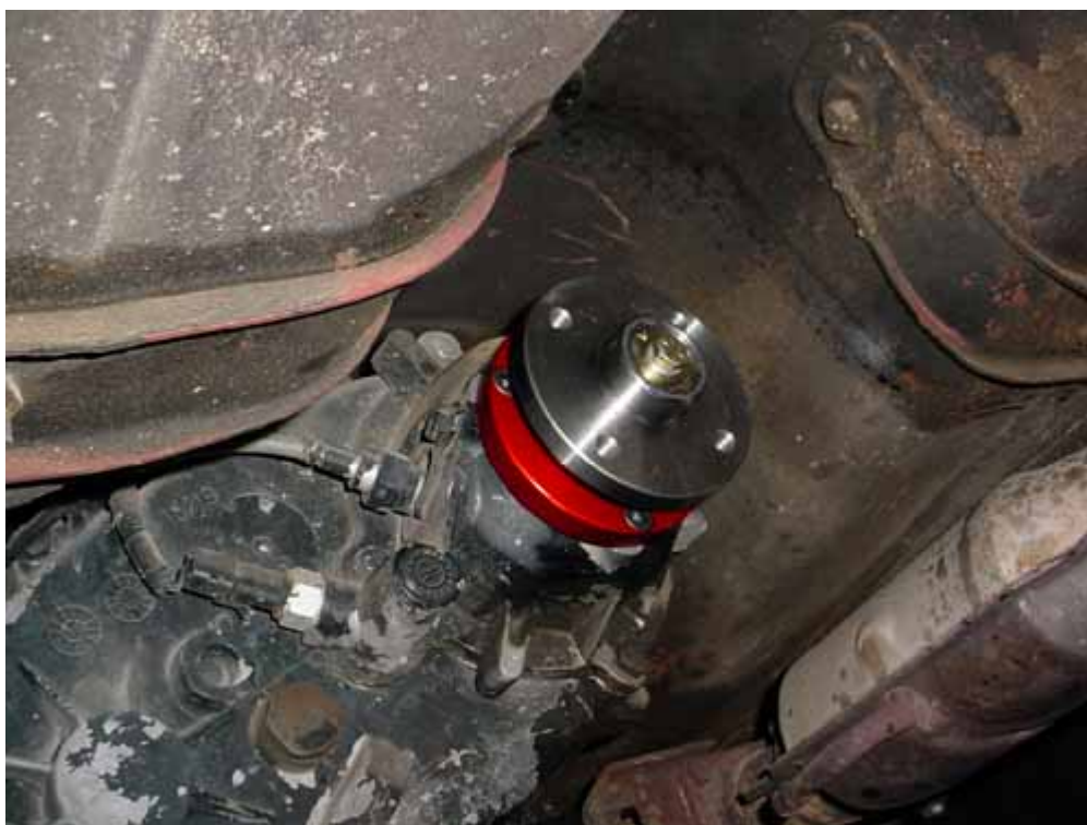
Flange do SYE instalada e travada.
