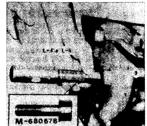
Fig. 42-E - Instalação das buchas.
